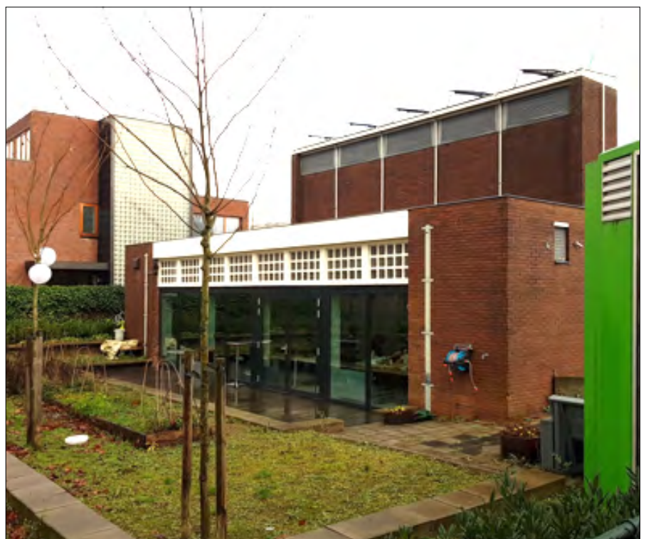
▲ Transformatorhuis aan de Blijdensteinlaan.
