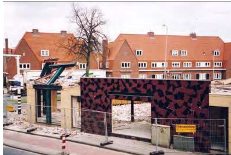
▲ 2005: de restanten van het pand van JHAB worden opgeruimd.
